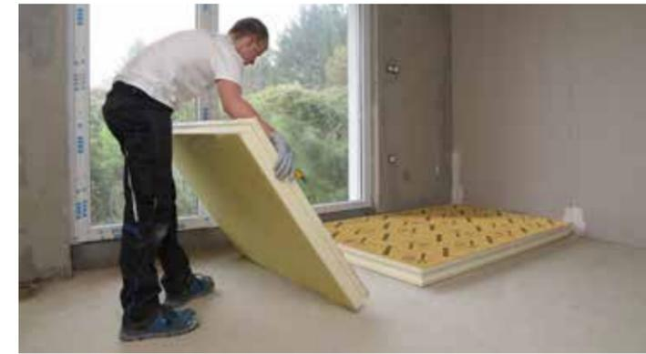
La plaque isolante Utherm Floor K Comfort dB est utilisée en neuf et en rénovation pour l'isolation thermique des sols et pour l'isolation acoustique aux bruits de chocs.
